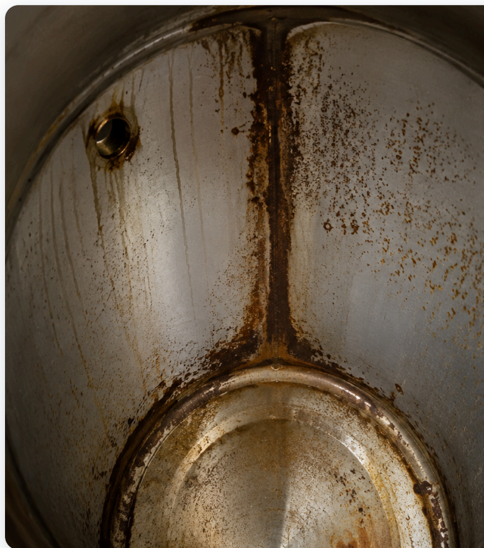
INOX CONVENCIONAL — corrosión por cloruros
